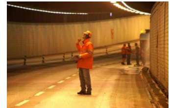
Sichtprüfung der Decke in einem Strassentunnel
