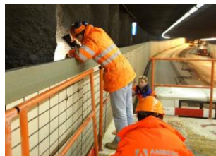
Inspektion eines Strassentunnels
