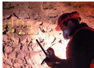
Verwendung eines Touchpads für die Tunnelinspektion
