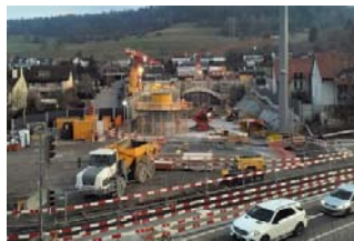
Neubau 3. Röhre Gubrist
