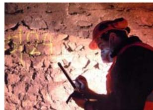
Verwendung eines Touchpads für die Tunnelinspektion
