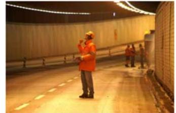
Sichtprüfung der Decke in einem Strassentunnel
