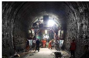
Verlegung der Bewehrung, wasserdichte Betonauskleidung Tunnel Zierenberg - Deutschland
