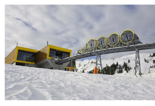
sind, das in der Bergstation über die Antriebsscheibe geführt wird. Dank der bodennahen Führung zeichnet sich die Standseilbahn auch bei widrigen Witterungsbedingungen durch eine hohe Verfügbarkeit aus. Aufgrund der Flachstrecken vor der Berg- und Talstation ist ein Gegenseil nötig, das in der Talstation mit einem Spanngewicht belastet wird. Dadurch wird die erforderliche Grundspannung erzielt, so dass der Wagen in die Talstation horizontal einfahren kann.
