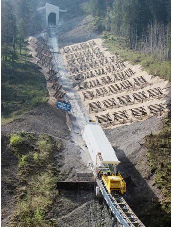
Anschliessend sind die vorgefertigten Betonelemente für den Gleiseinbau versetzt und verankert worden.
