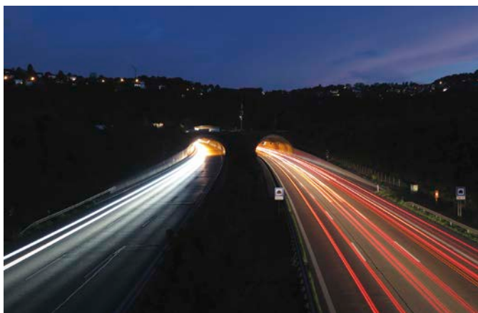
Bild 1 Südportal des Engelbergtunnels South portal of the Engelberg Tunnel
