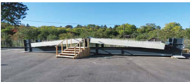
Bild 8 Probebauteil Zwischendecke [3] Trial building element, intermediate slab [3]
