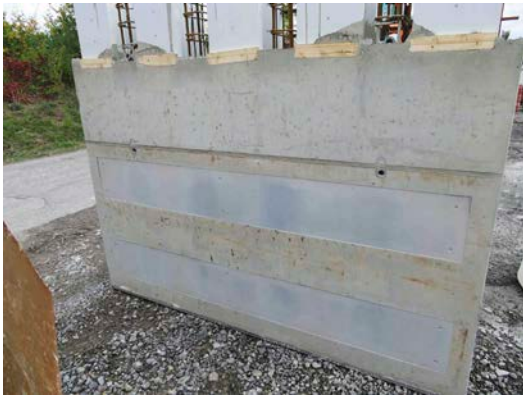
Bild 6 Versuchsaufbau Vorsatzschale – ausgeschalte Wand Trial of additional lining – wall with formwork struck
