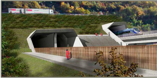
■ Nordportal in Vigana
