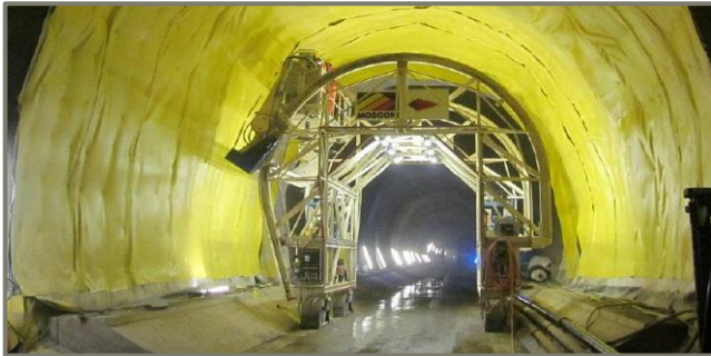
■ Abdichtung und Erstellung der Verkleidung
