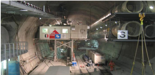
■ Bauinstallationen im Abschnitt Sedrun
