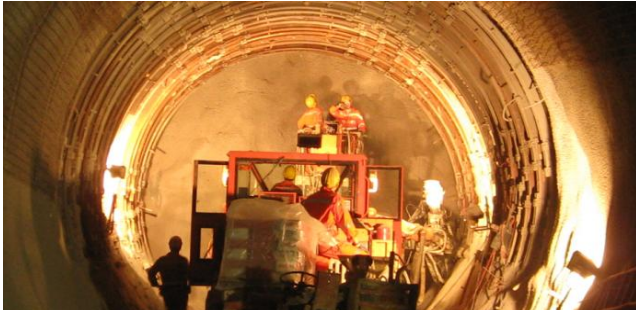
■ Felssicherung mit Stahleinbau in einer Störzone
