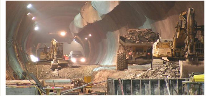
■ Abraumtransport in Bereich des Südportals
