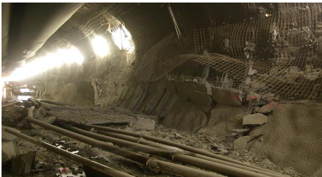
■ Bergschlag bei der Multifunktionsstelle Faido
