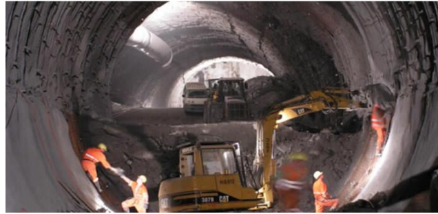
■ Schwieriger Fels im Bauabschnitt der MFS Faido
