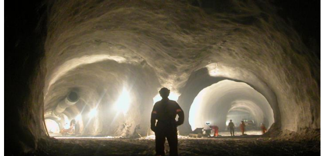
■ Fertigstellung Vortrieb in der MFS Faido
