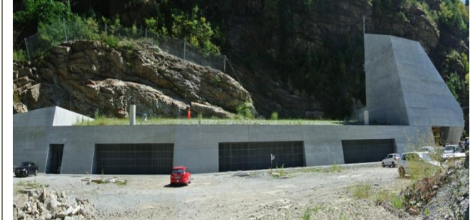
■ Lüftungsbauwerk bei Faido
