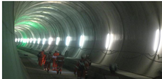
■ Rohbau fertiger Tunnelabschnitt
