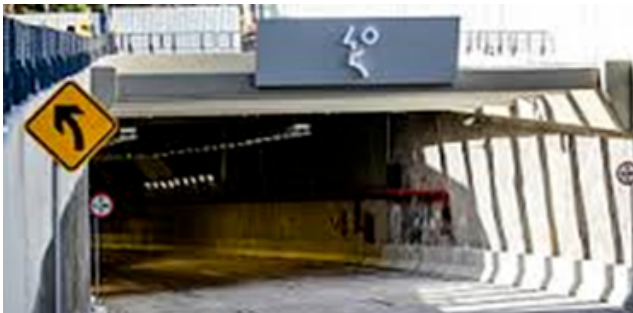
■ Eingangsbereich des Rio450 Tunnels
