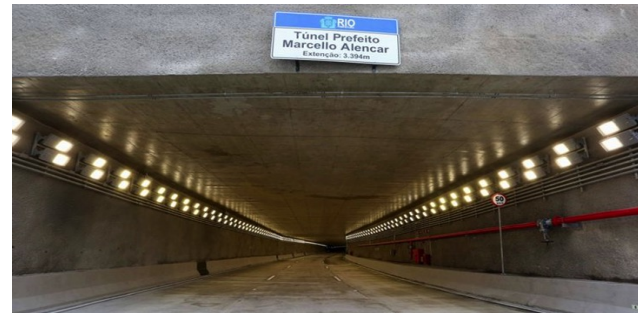
■ Ansicht des Portals des Rio450 Tunnels
