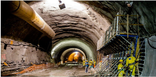
■ Vortrieb des Rio450 Tunnels
