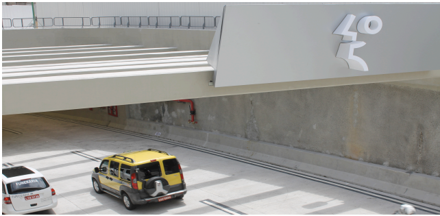
■ Ansicht des Tunnelleingangs Rio450
