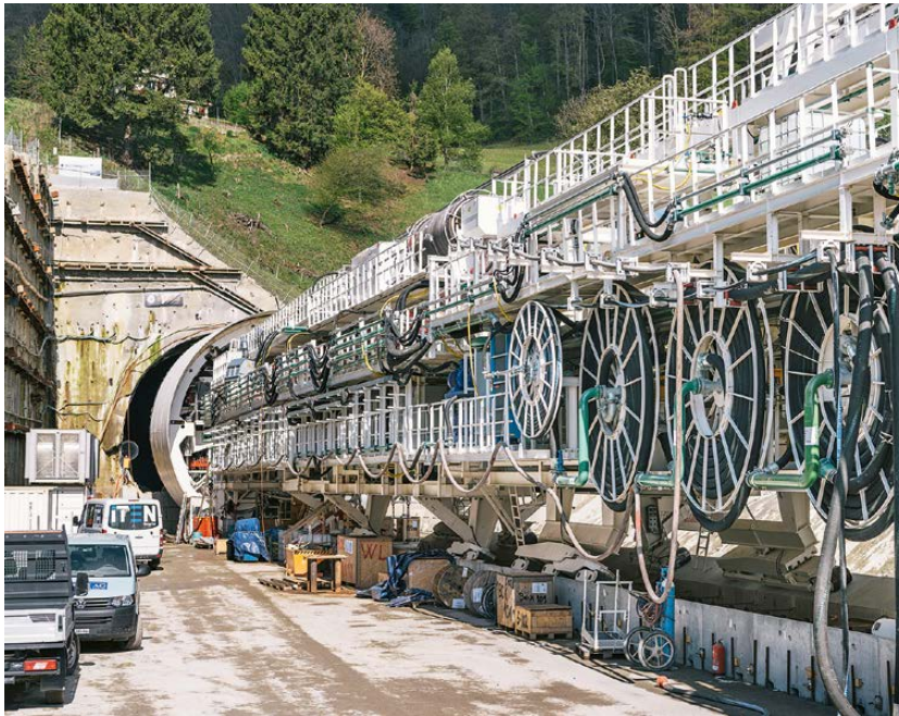
Voreinschnitt Schinznach mit installierter Tunnelbohrmaschine vor dem Portal des neuen Bözbergtunnels. Links die rückverankerte Bohrpfahlwand.
